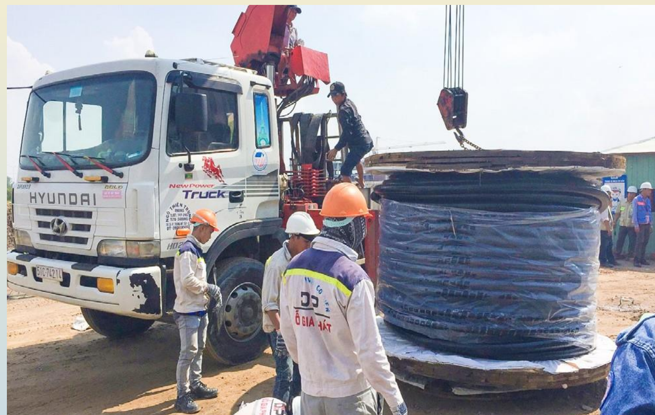
Thi công cáp động lực
