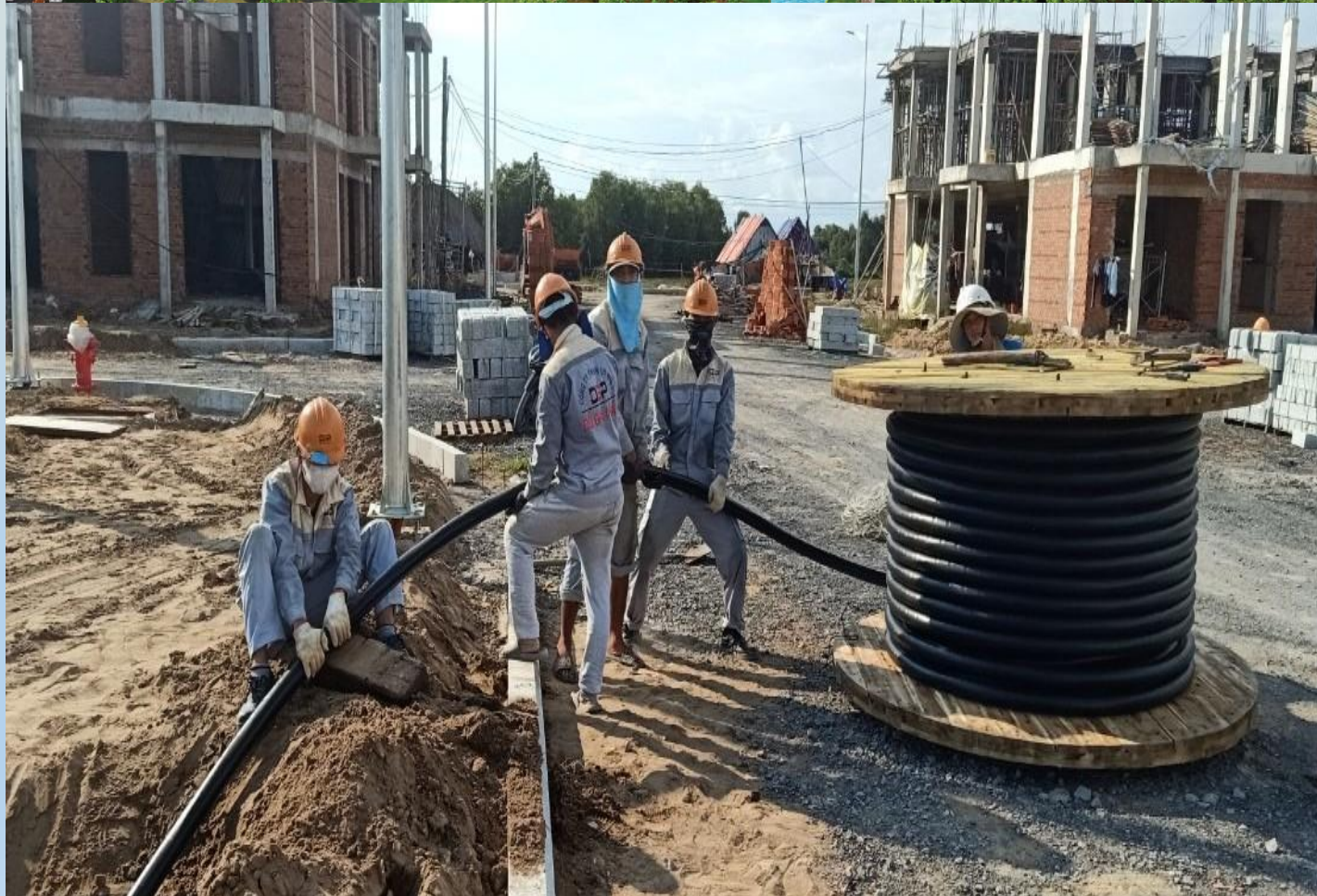
Thi công cáp ngầm hạ thế
