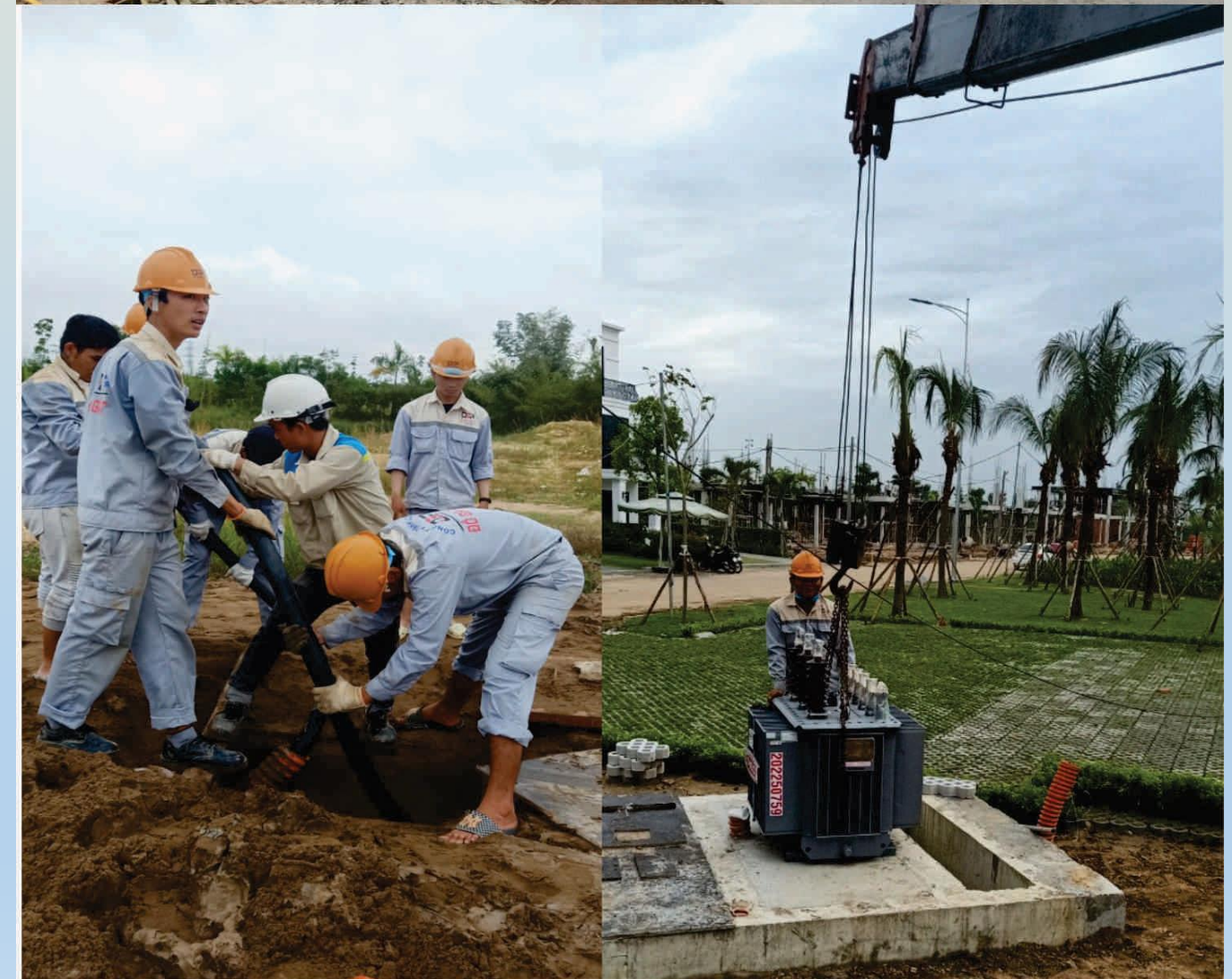
Thi công cáp ngầm vào trạm hạ thế
