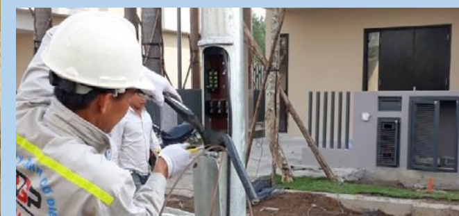
Thi công và lắp đặt trụ đèn
