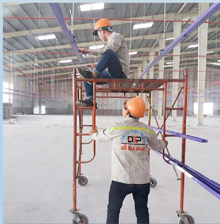
Thi công máng cáp
