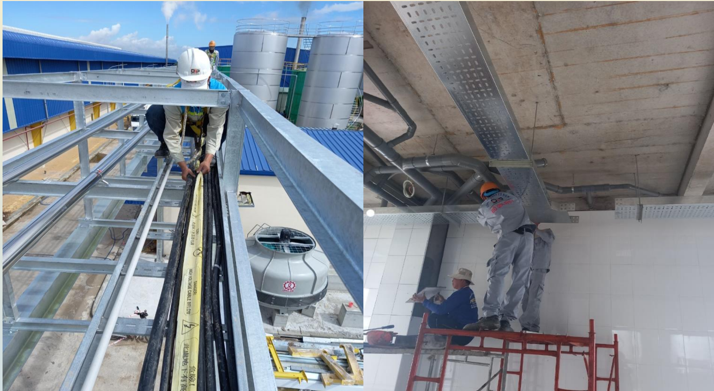
Thi công thang cáp &amp; kéo dây động lực
