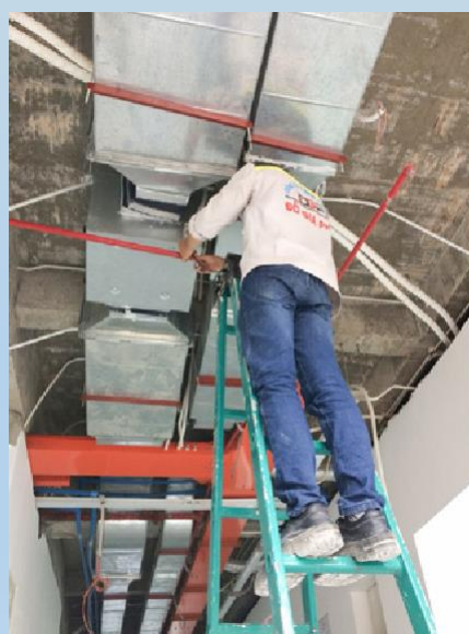
Lắp đặt hệ thống thông gió
