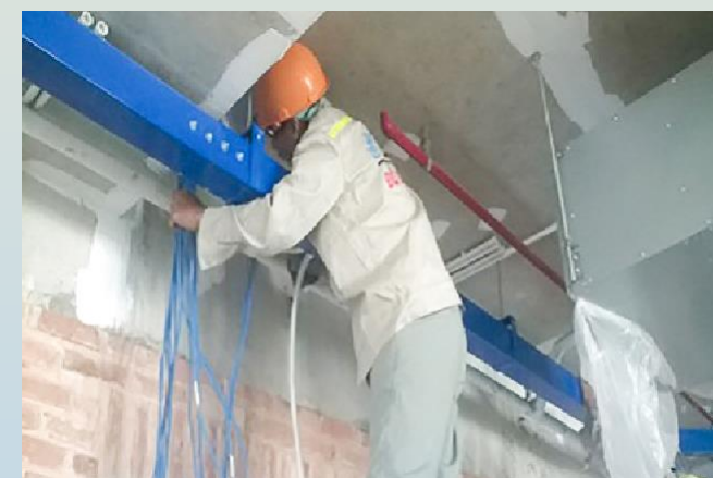
Thi công lắp đặt Trunking
