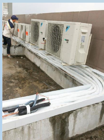
Lắp đặt hệ thống lạnh cục bộ
