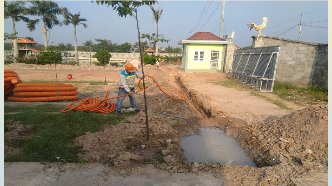
Thi công hạng mục chiếu sáng công cộng
