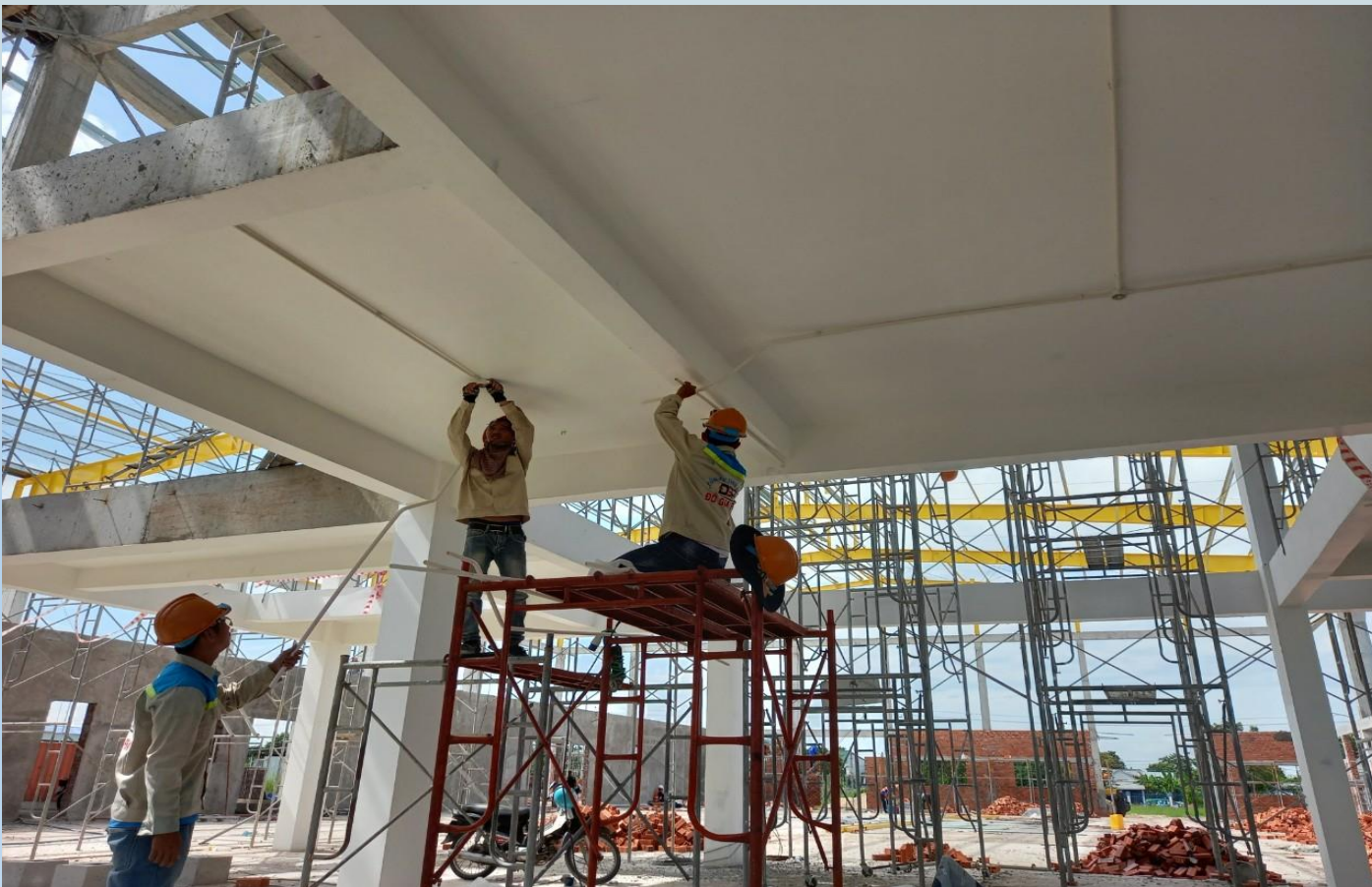
Thi công bắn ống nổi hạng mục chiếu sáng
