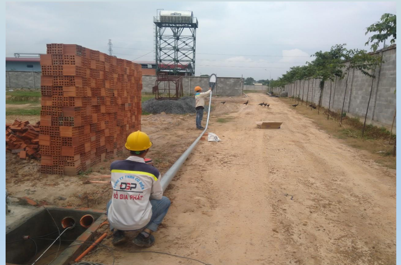
Lắp dựng đèn đường chiếu sáng công cộng
