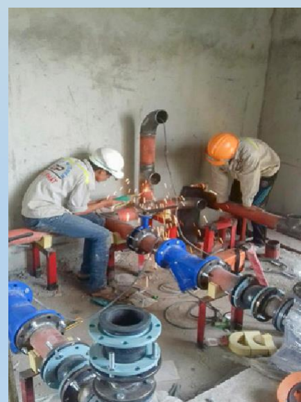
Lắp đặt phòng bơm Chiller
