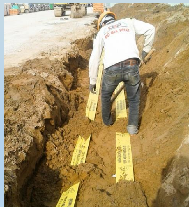
Thi công hệ thống cáp ngầm
