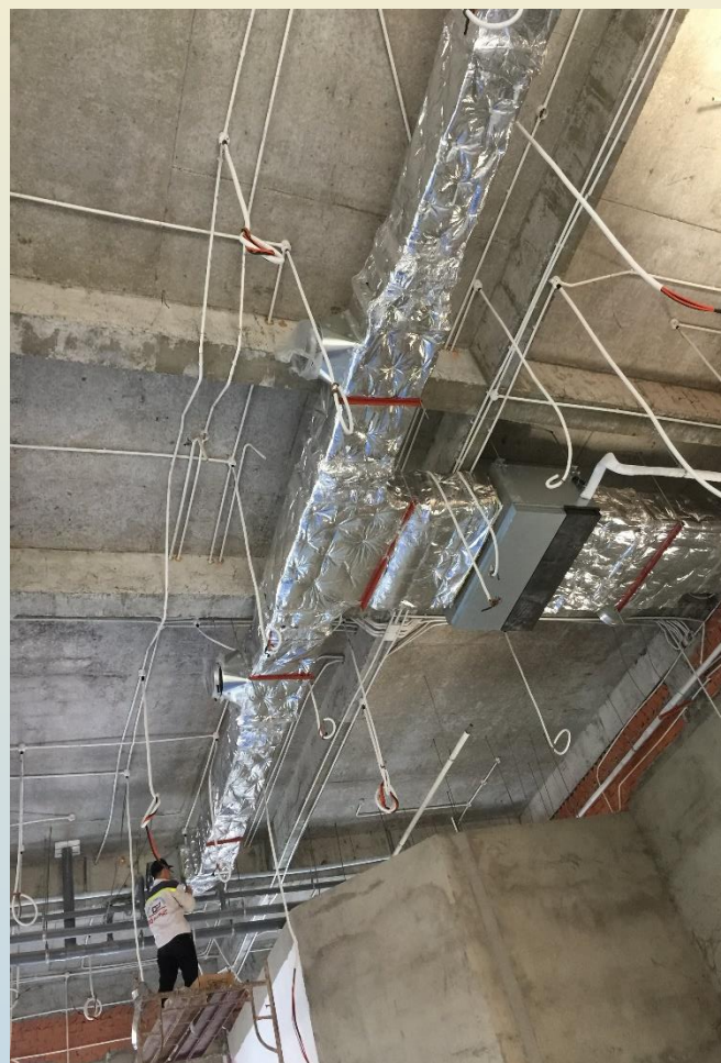
Lắp đặt hệ thống điều hòa không khí
