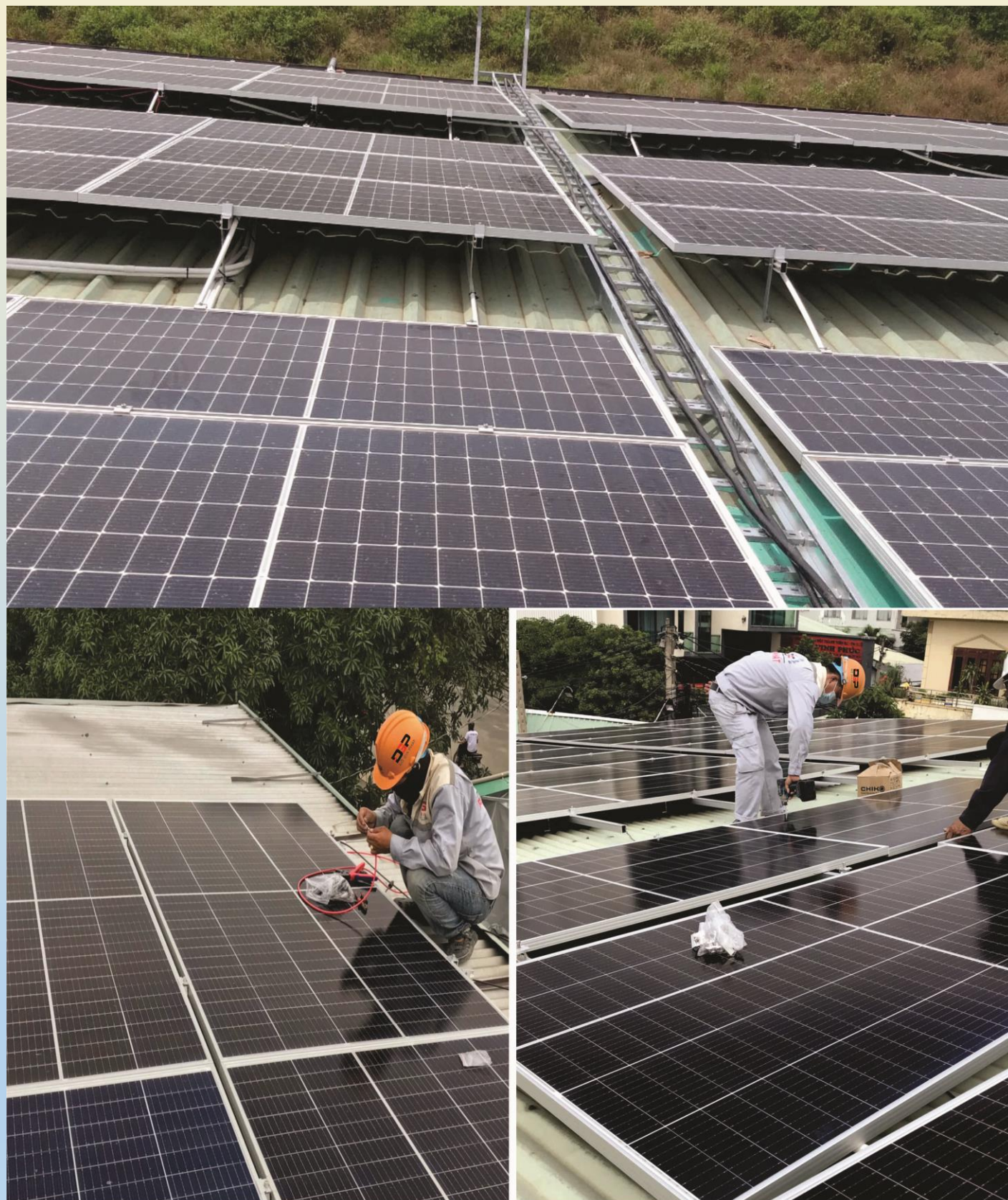
Thi công lắp tấm pin NLMT
